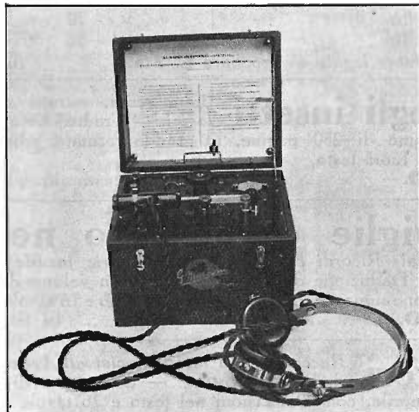
APPARECCHIO RICEVITORE A CRISTALLO PER RADIOTELEFONIA
